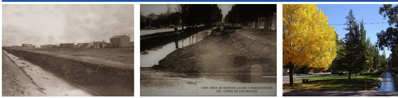
Fig.2 Imágenes, desde la construcción del “Canal de los Milicos” al “paseo del Canalito”
